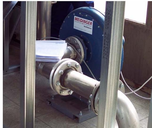
Fachmännisch verbaute Kompensatoren an einem Verdichter
