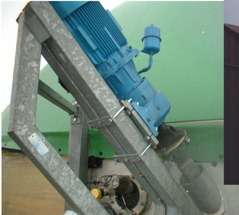
Gegen Schwingungen gesichertes Rührwerk
