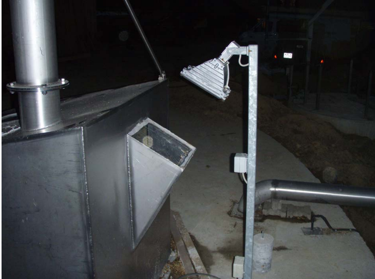
Bild 8 Gasdom mit Zone 2 und unzulässiger Elektroinstallation
