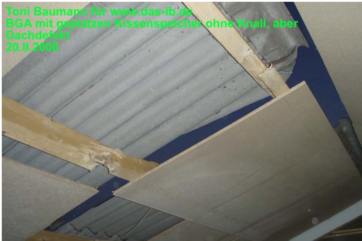
Bild 2 Aufgerissene Dachkonstruktion
