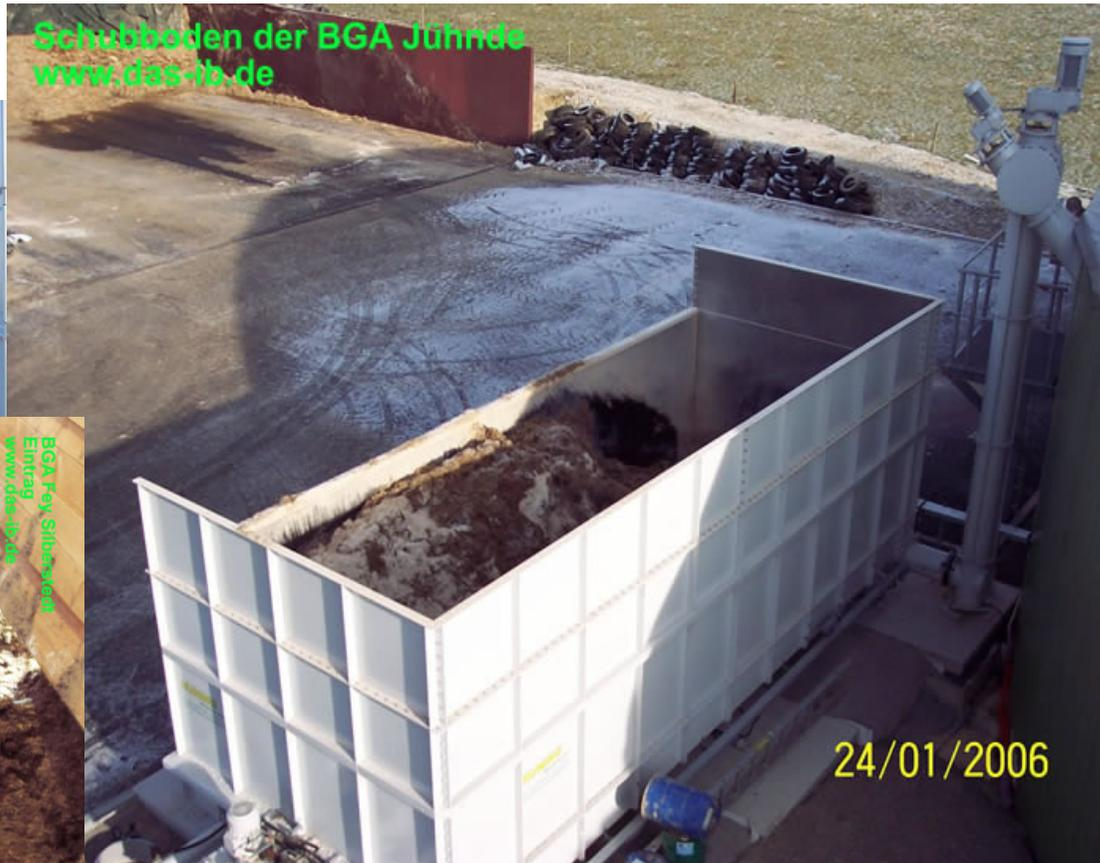
Abb.: Feststoffeintrag mit Schubboden und Förderschnecken
