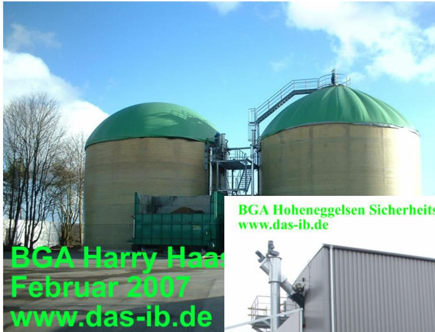
Abb. oben: Fermenter mit Zentralrührwerk und Nachgärer
