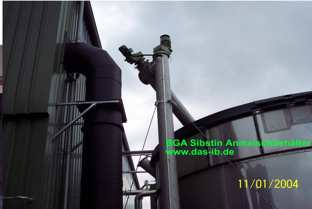
Abb. oben: Pumpstation für flüssige Substrate
