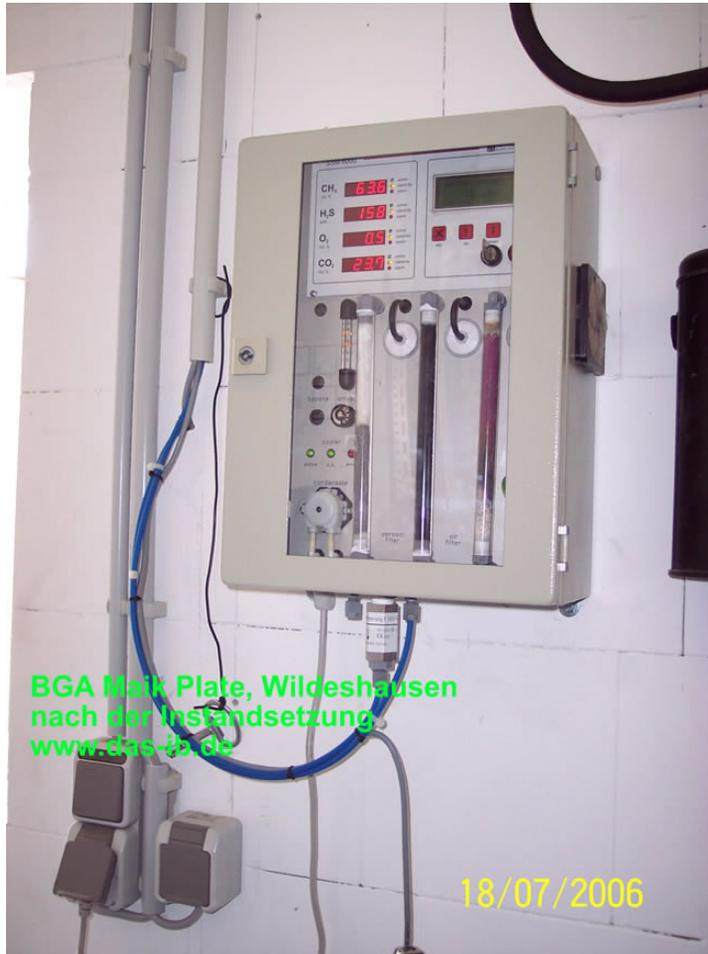
Abb. links/ unten: Rohgasanalytensysteme
