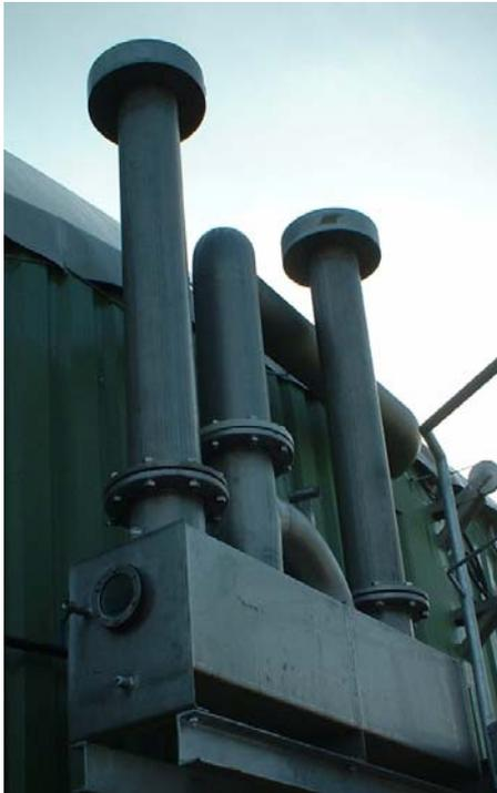
Überdruck-/Unterdrucksicherung am Fermenter
